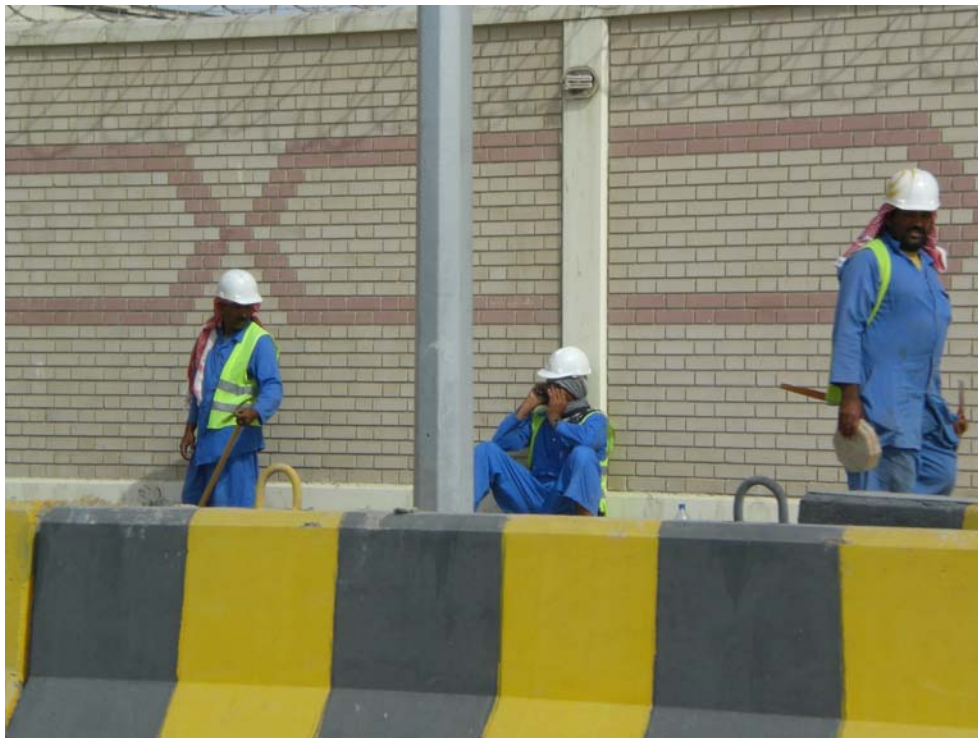
Straßenbauarbeiter in Abu Dhabi (M. Schnepf-Orth)
